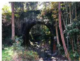
逆谷橋(筑後軌道の橋)
